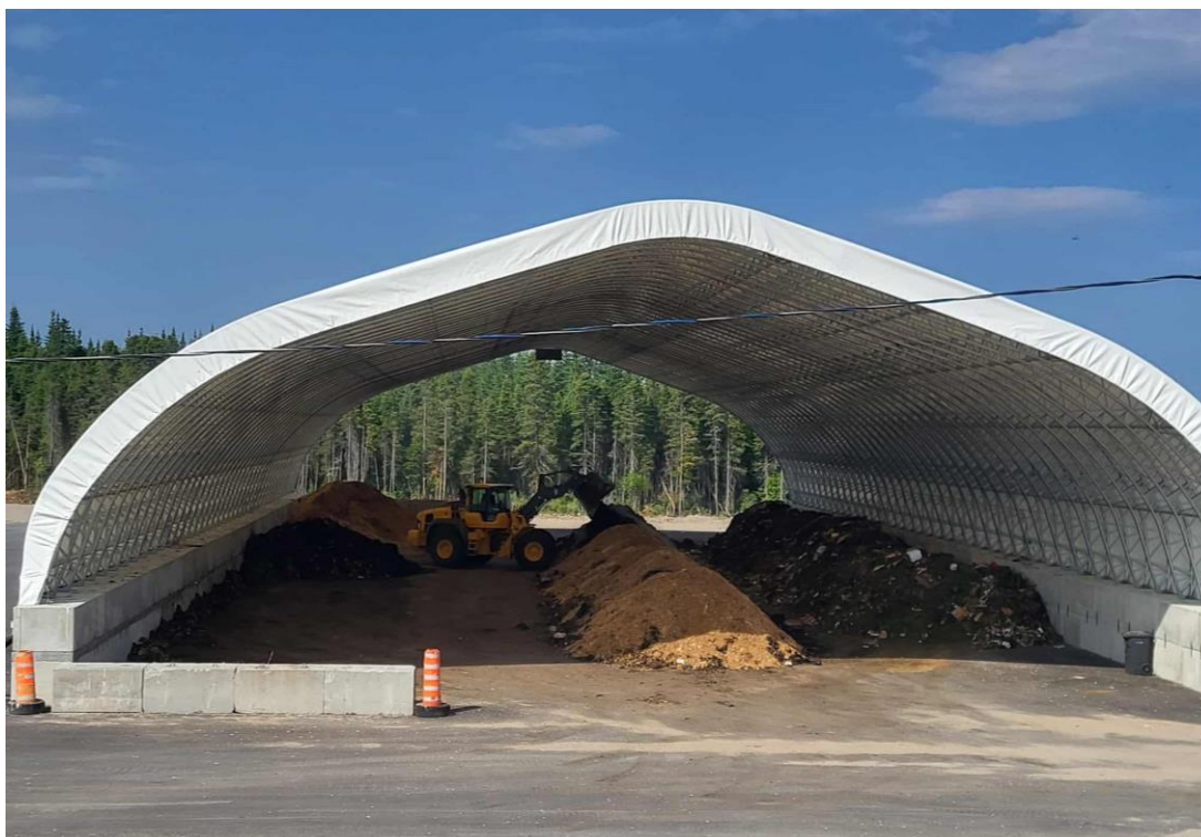
Opération d'ajouts de structurant (copeaux de bois). Au 6 juin, 454 tonnes de matières organiques ont été reçues à la plateforme de compostage.
