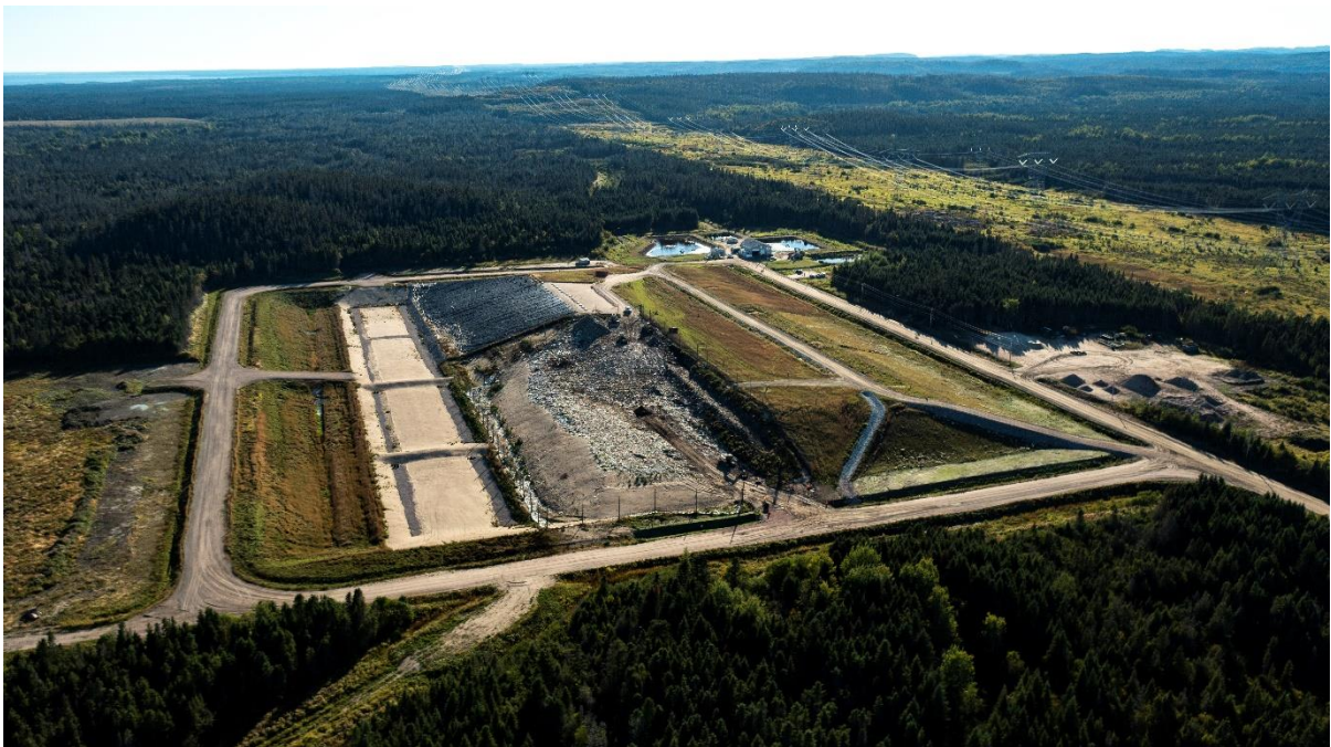
Vue aérienne du lieu d'enfouissement technique de Ragueneau (Source : RGMRM)
