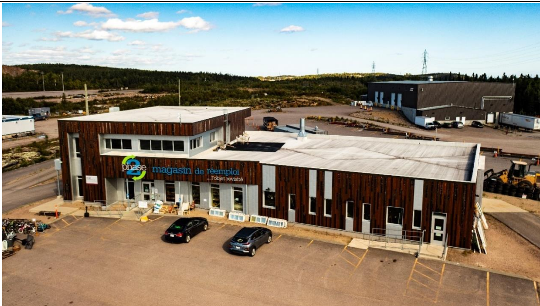
Magasin de réemploi Phase 2 (Source : RGMRM)
